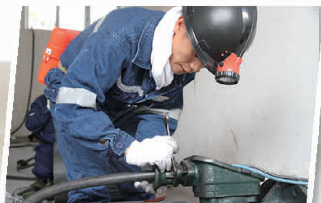
防爆检修组——安装井下防爆电机和开关
