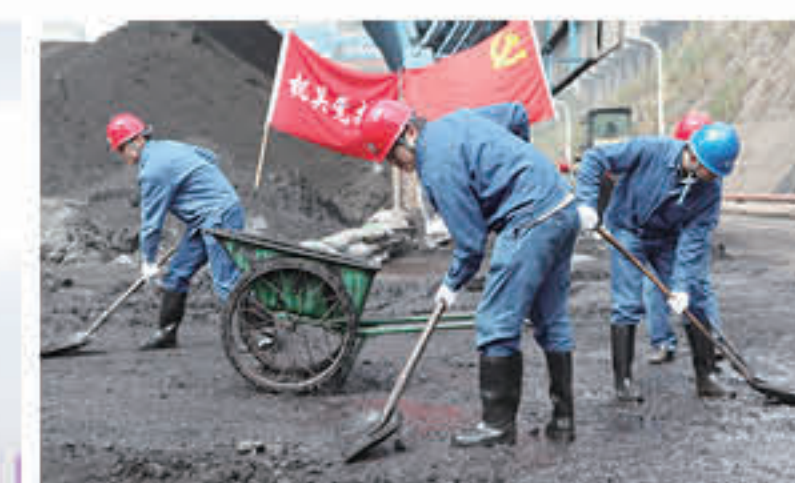
盘南电厂党支部志愿服务活动清理卸煤沟
