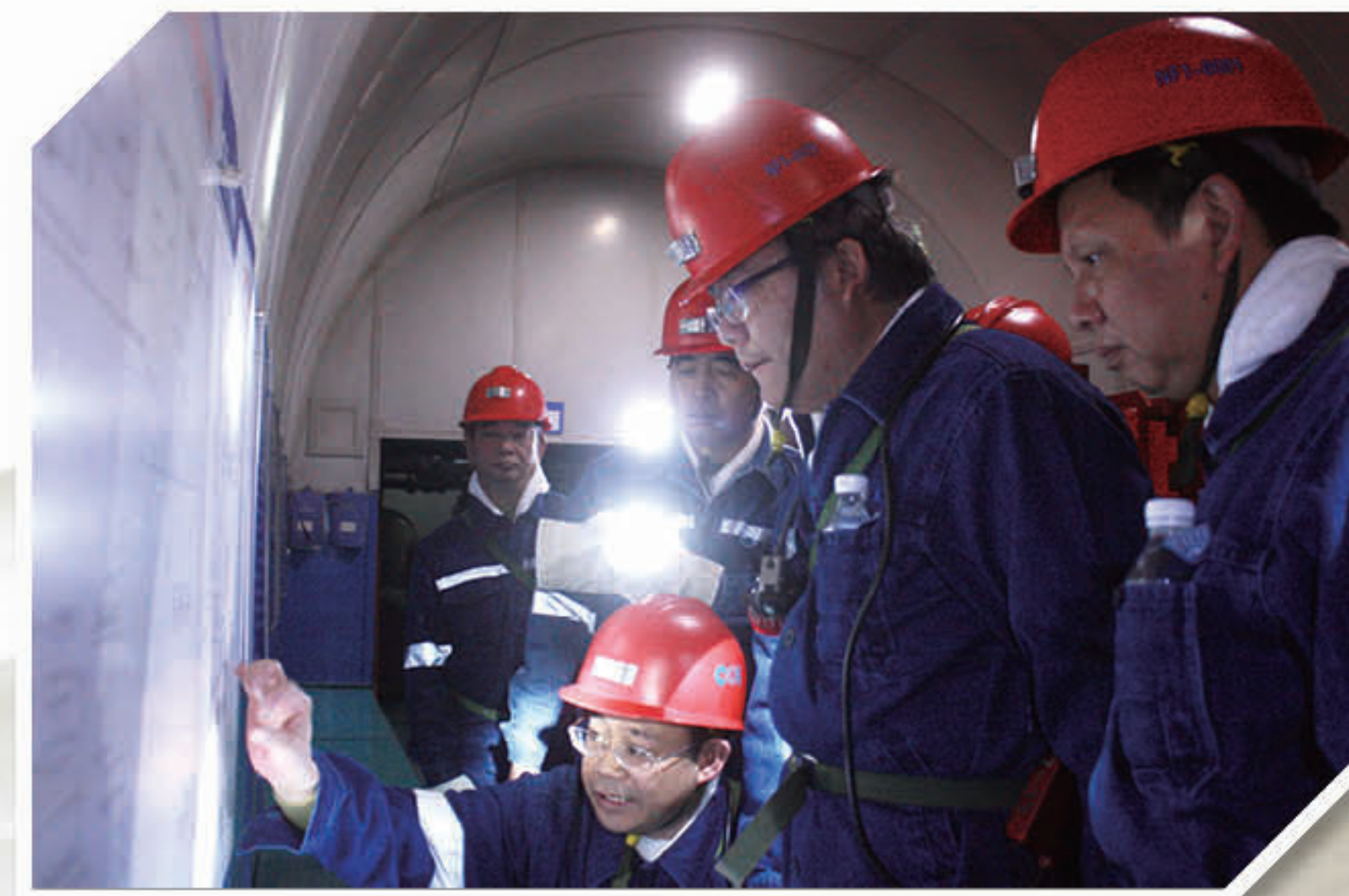
◎ 2013年12月12日，贵州省副省长何力到林华煤矿进行安全检查，图为到现场查看水泵房供电情况
