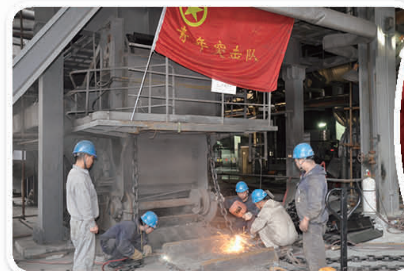
黔西电厂青年突击队检修2号炉捞渣机
