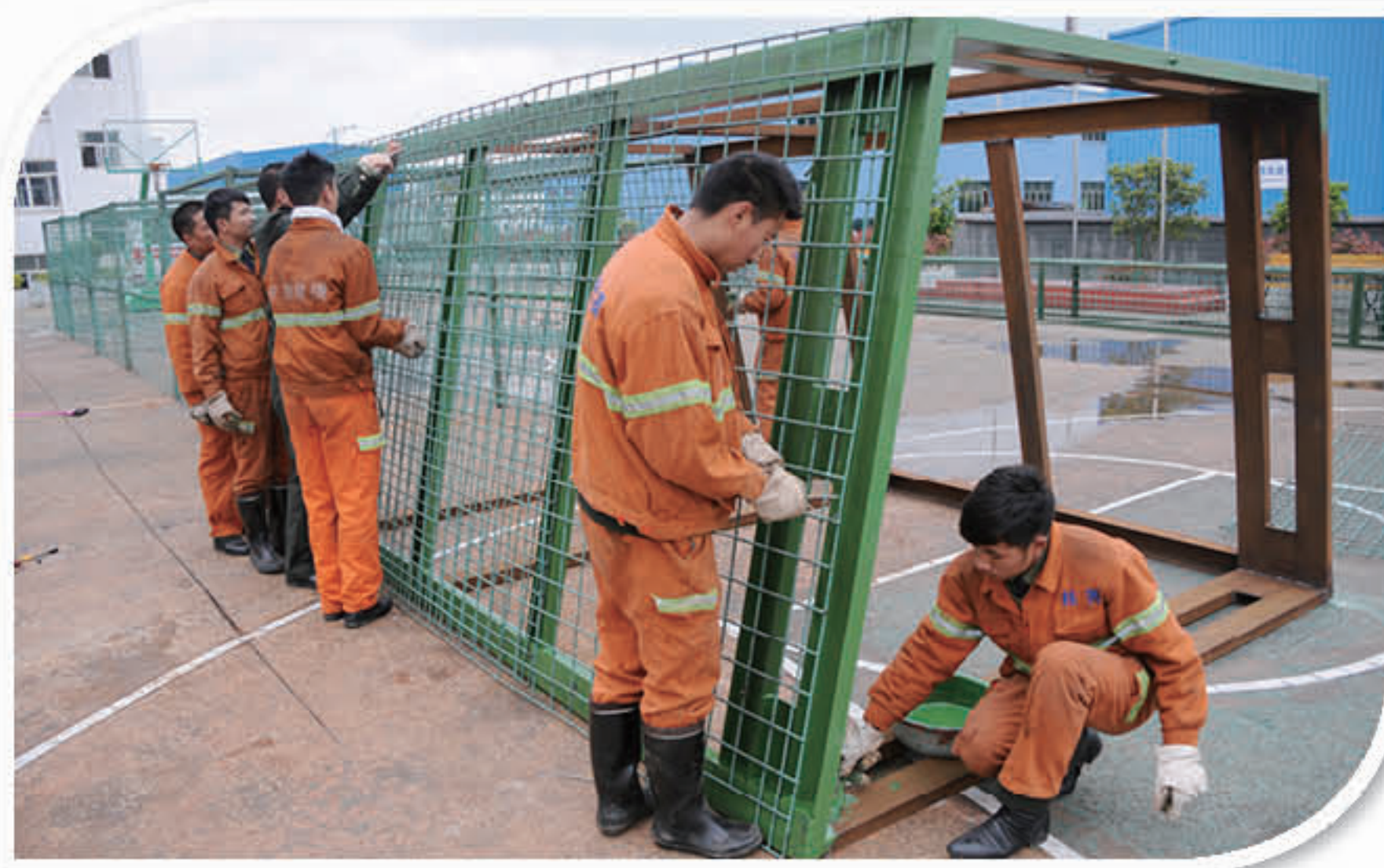
◎ “变废为宝”，用废旧钢材制作煤矿模拟巷道
