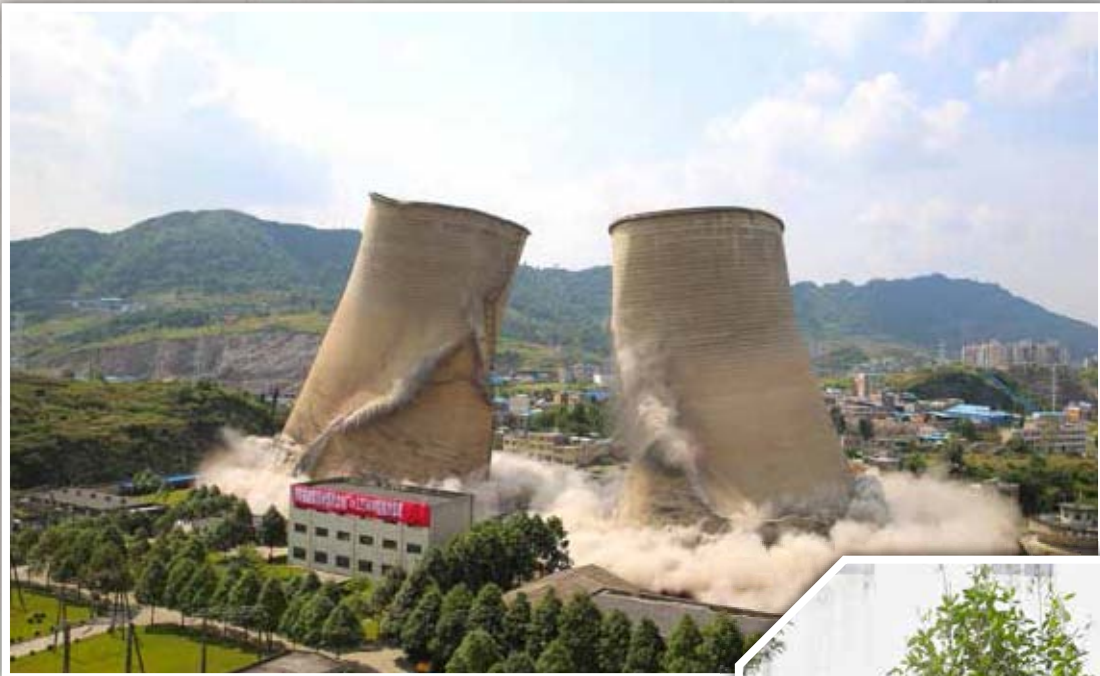
黔北电厂 4 台 125 兆瓦机组冷却塔成功爆破
