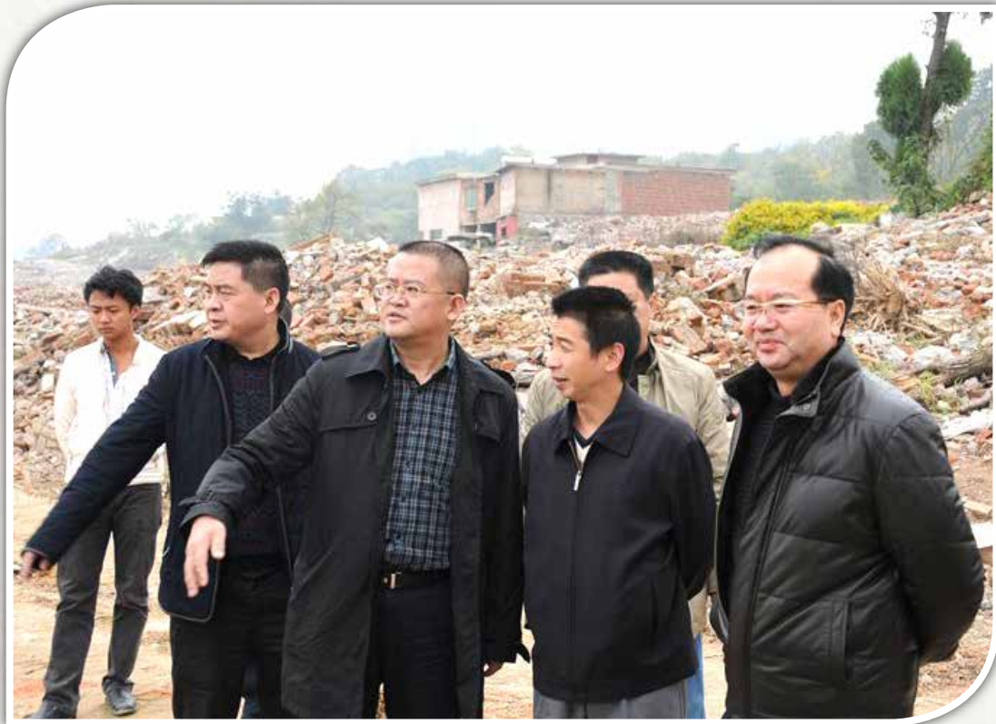
2014年11月19日，金元集团副总经理马刚到元龙公司“印象·花溪”项目工地调研
