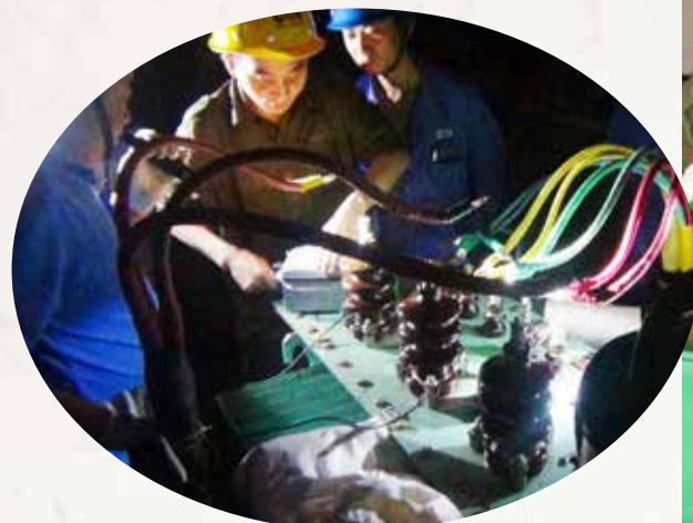
电站职工测量厂用变压器绝缘
