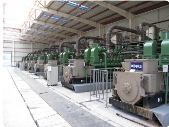
林华瓦斯电厂（林华矿瓦斯电站：现20台500KW机组规模的厂房和厂区附属设施于2010年9月建成，已安装15台500KW发电机组，2012年6月正式并网发电；）
