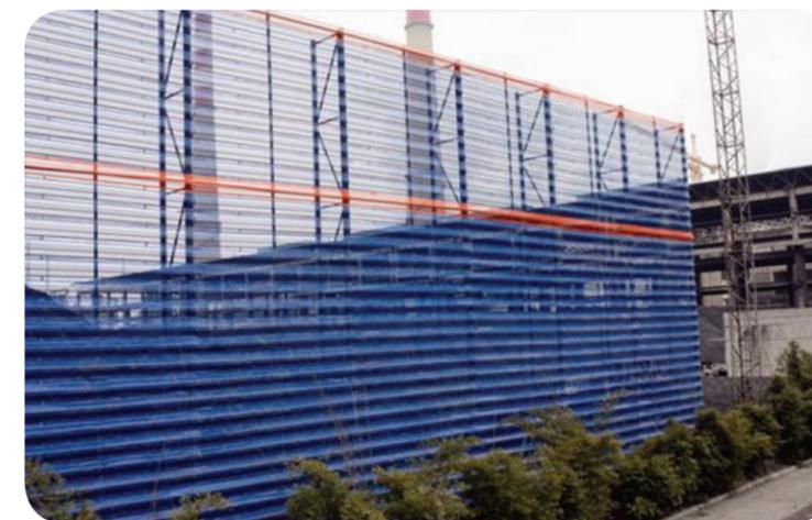
黔北电厂建成投入使用的防风抑尘墙
